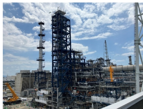
大阪府堺市で建設中の SAF 製造工場の様子
